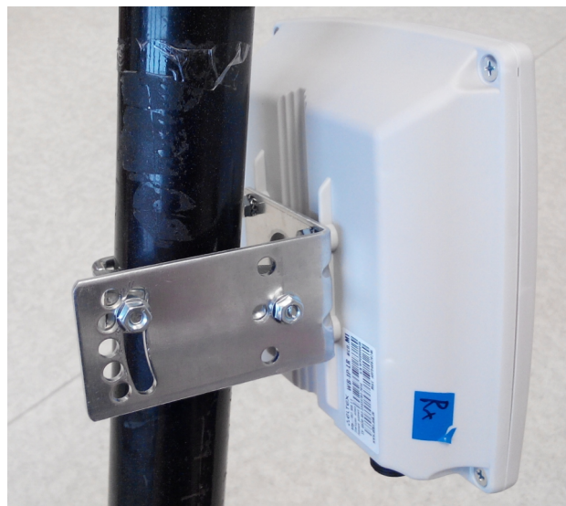
Рисунок 11 – Вид правильно установленной станции
