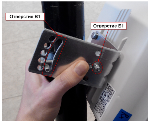
Рисунок 10 – Установка кронштейна на мачту
