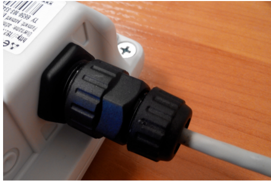
Рисунок 17 – Вид подключенного кабеля к сетевому интерфейсу устройства
